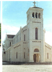
破壊される前の聖堂（1967年）⇒
